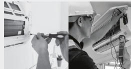
Schwieriger elektrischer Anschluss
