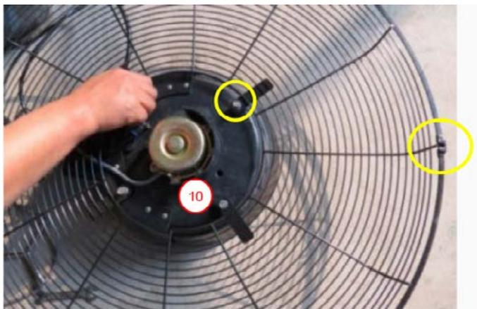
12. Suspenda la protección delantera y el enganche la carcasa trasera y bloquee con la abrazadera lateral.
