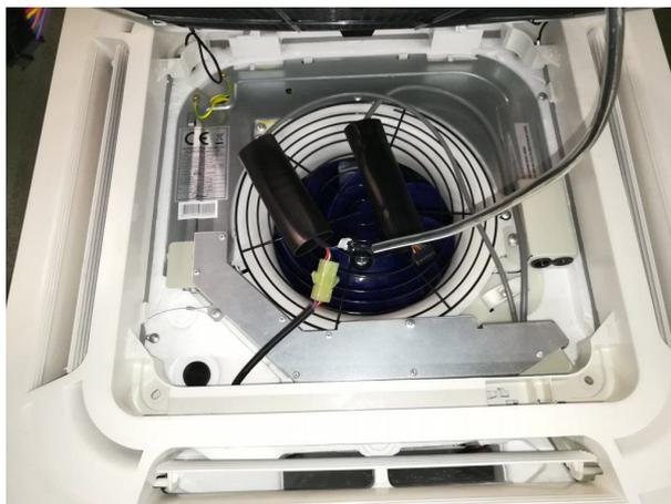
5.4 Bewegen Sie die Hülse in die Mitte der Anschlüsse und verbinden Sie die Enden der Hülse mit den Flanschen sicher. Schneiden Sie die zusätzlichen Teile des Spannflansches ab.
