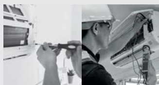
Ligação elétrica difícil
