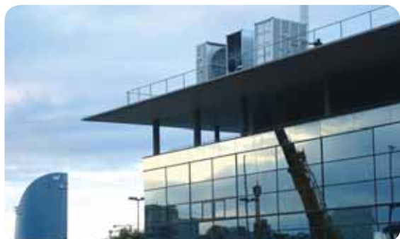
Centro Comercial MAREMAGNUM (Barcelona) Recuperador rotativo 35.000 m 3 /h
