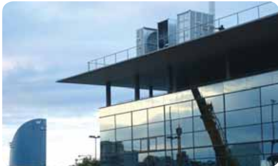
Einkaufszentrum MAREMAGNUM (Barcelona) Maxi MVD, Kühlleistung 450 kW
