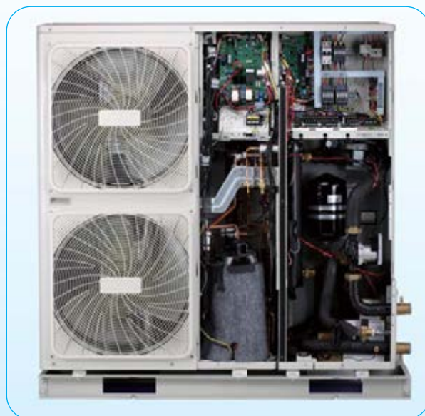
Puerta 2: Acceso a los componentes con refrigerante y componentes eléctricos
