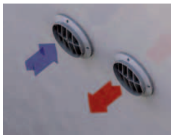
Grille extérieure de EPDM (patentée)
