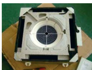
Rejilla de protección en ventilador para evitar intrusiones
