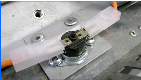
fig.10. Thermal cut-out
