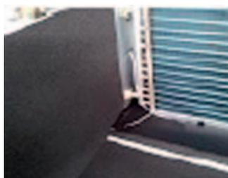
El respiradero está dispuesto de fábrica en la parte del colector y conectado a una bandeja colectora de condensados
