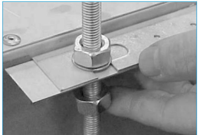
Ejemplo de fijación de la cortina mediante espárrago roscado.
