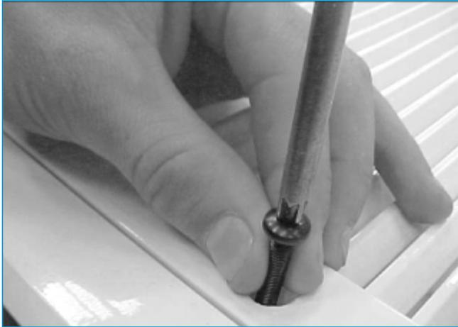
Después de fijar la cortina de aire al techo, ajuste la altura y coloque la rejilla mediante los dos tornillos extraídos en el paso 2 y los dos embellecedores correspondientes, extraídos en el paso 1.
