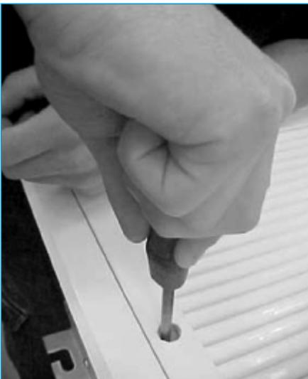
Retire los tornillos tipo M5 con un destornillador a través de los agujeros de acceso. Para facilitar la reinserción de la rejilla, los tornillos tienen una longitud de 50 mm, y será necesario volver a enrosarlos. Extraiga la rejilla para poder fijar la unidad al techo.
